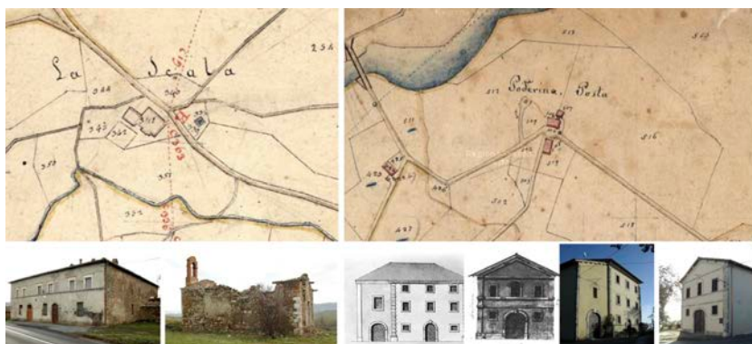
Figura 3. Le stazioni di posta della via senese: a destra, il complesso de La Scala d'Orcia nel 1823 (Archivio di Stato di Siena, d'ora in poi ASSI, Catasto Leopoldino, Castiglione d'Orcia, Sez. C, f. 2 n. 9 e due immagini dello stato attuale tratte da Google Street View). A sinistra il complesso della posta della Poderina nel 1823 (ASSI, Catasto Leopoldino – Castiglione d'Orcia – Sez. B, f. 2, n. 5), due disegni dei prospetti della fabbrica della posta e della stalla e fienile (ASSI, Reali poste, n. 10) e due immagini dello stato attuale (da Google Street View)
