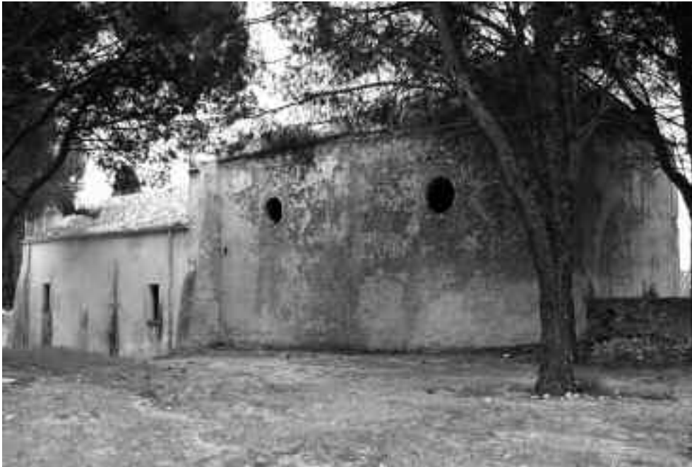
Fig. 9 - Il corpo antico della chiesa (a dx) addossato a quello di più recente fattura
