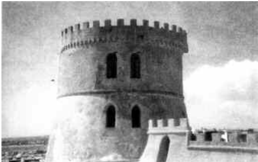
Fig. 10 – Marciano di Leuca: Torre Vado, a base troncoconica e corpo cilindrico oltre il cordolo, presenta finestre ogivali e beccatelli
