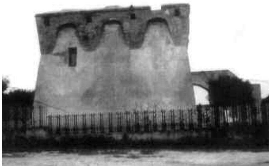
Fig. 16 - Taranto: Torre S. Vito è una poderosa torre tipica del viceregno, dotata di tre caditoie e di una grande scala esterna
