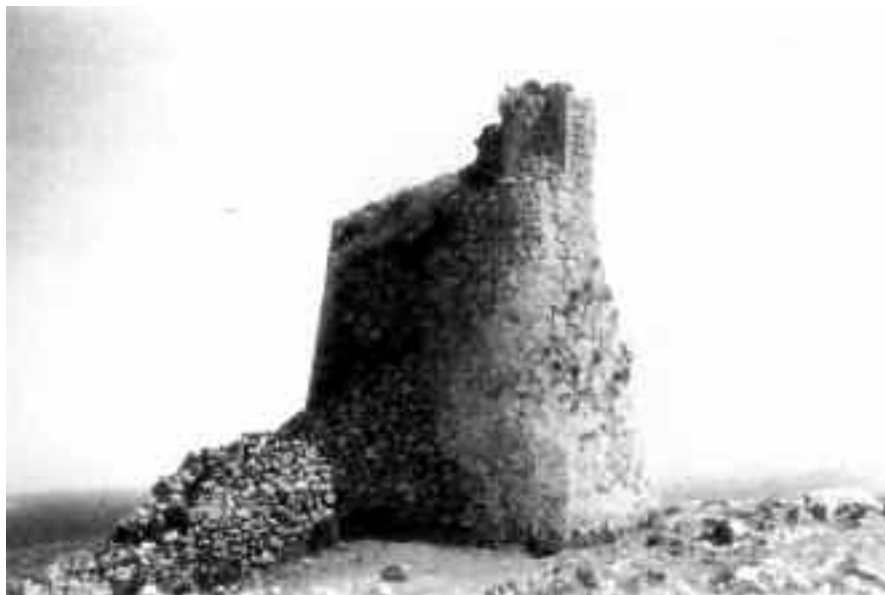
Fig. 6 - S. Cesarea Terme: Torre Minervino, a base troncoconica, conserva una parte del modesto cordolo e coronamento a scarpa
