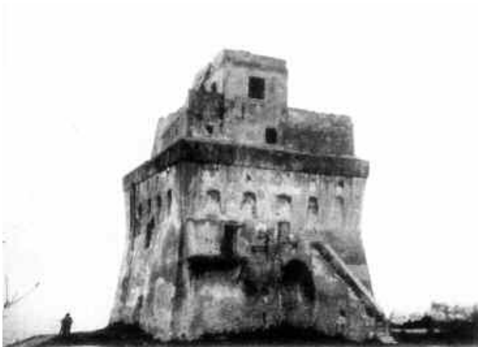
Fig. 2 - Sannicandro Garganico: Torre Mileto, a base quadrata e corpo troncopiramidale con cinque caditoie a sbalzo per ciascun lato, conserva la scala esterna, caratteristica della serie di Nardò
