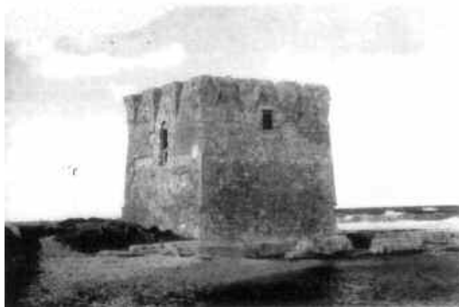
Fig. 4 - Polignano a Mare: Torre S. Vito, a base quadrata, presenta tre caditoie in controscarpa
