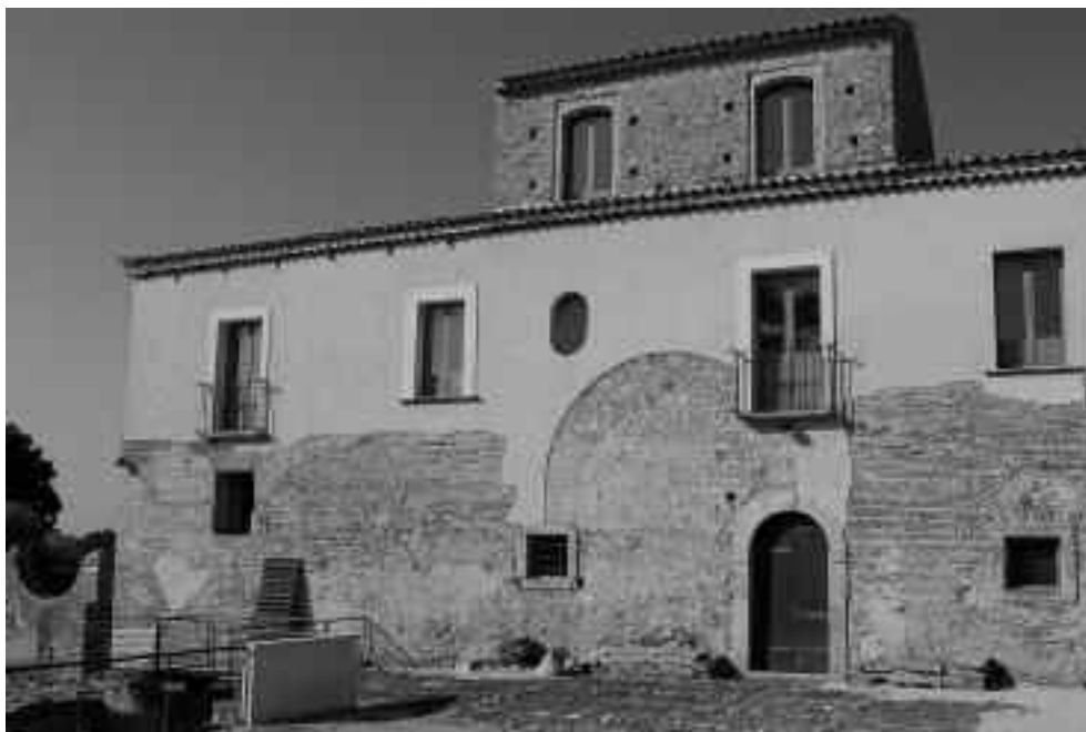
Fig. 12 - Strutture di epoca romana nella facciata del 'Casino Macri'
