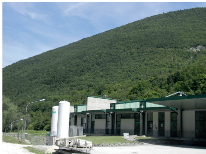
Figura 8. Lo stabilimento di imbottigliamento dell'acqua Nera, nella zona industriale di Castelsantangelo sul Nera (MC).
