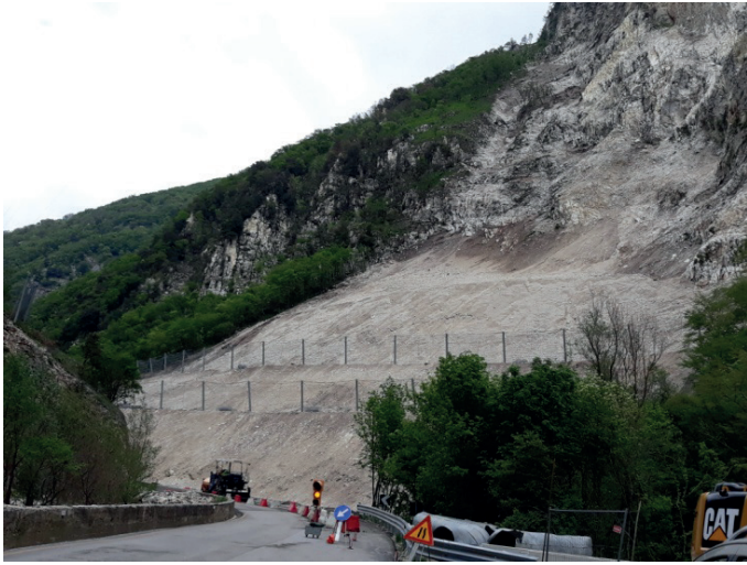
Figura 1. Ancora nel maggio 2018 si evidenzia il senso di marcia unico alternato e il visibile corpo di frana messo in sicurezza con reti paramassi sul tratto interessato della SP 209 Valnerina 4 .
