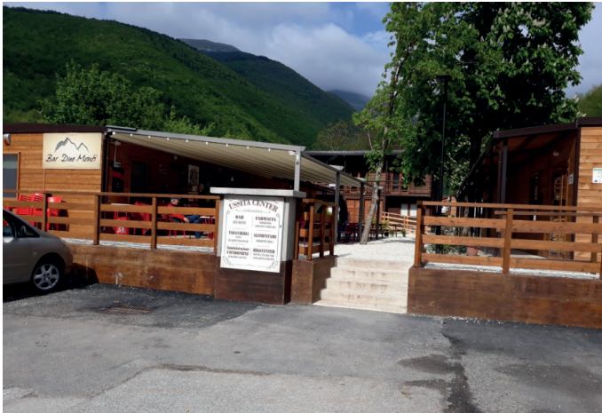
Figura 5. L'Ussita Center, area commerciale dotata di servizi essenziali (alimentari, bar, farmacia, tabaccheria) presente dall'ottobre 2017 nella frazione di Fiuminata (Ussita, MC).
